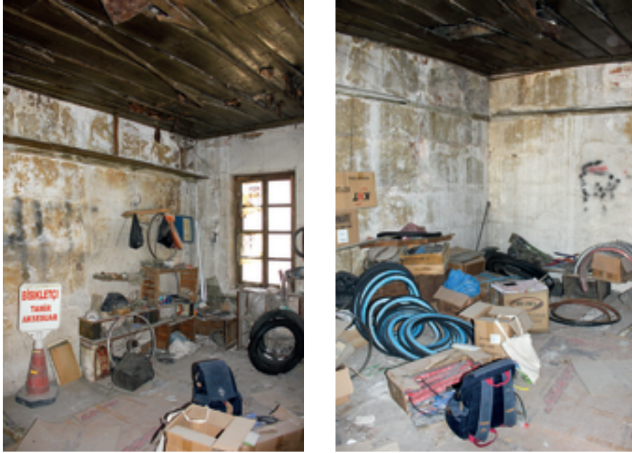
Şekil 3: Yapı iç görünümü 1-01.
