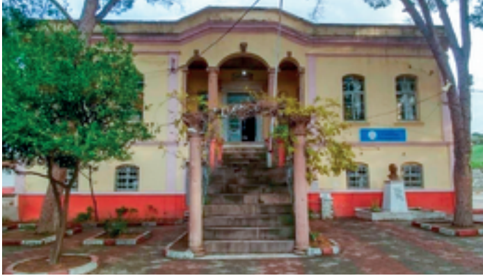
Şekil 1a: Çamdibi ortaokulunun batı (ön) cephesi.
