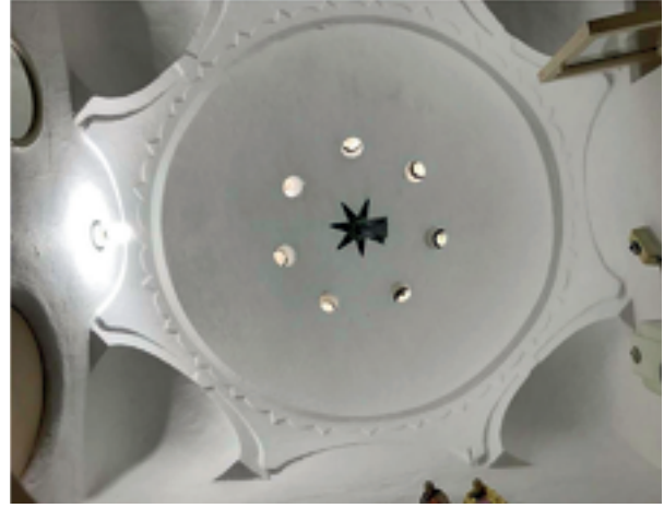
Şekil 4: Hamam kubbe iç görünüşü 2019.
