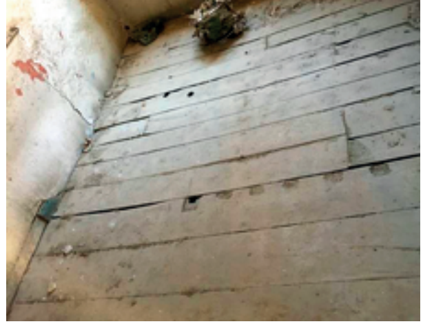
Şekil 4: Birinci katta, kaldırılmış merdivenin korkuluğu izi.
