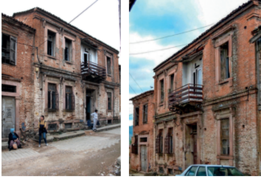
Şekil 1: Ön cepheden görünüm.
