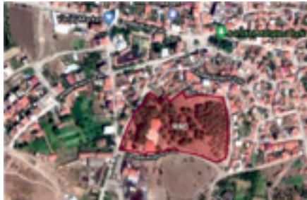
Şekil 3a: Çamdibi Ortaokulu ve çevresinin gösteren hava fotoğrafı.*
