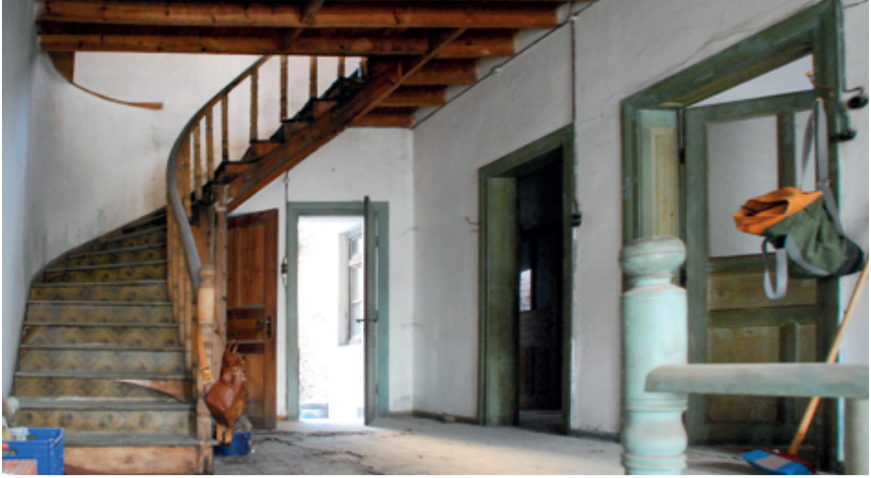
Şekil 2: Zemin kat iç mekân görünüm.
