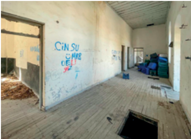
Şekil 5: Giriş holünden sınıf girişleri ve müdür odası girişine bir bakış (Korkmaz, 2022).
