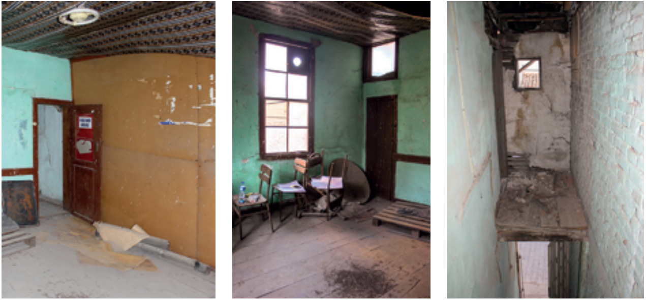
Şekil 4: Yapı iç görünümü 1-01.
