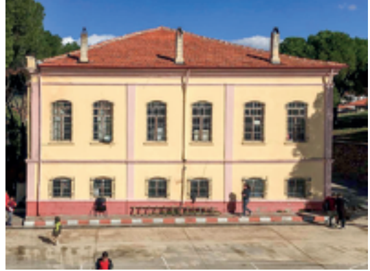
Şekil 1b: Güney (sağ yan) cephesi.
