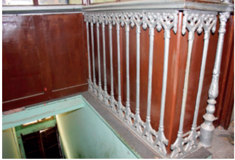
Şekil 2: Yapı iç görünüşleri.
