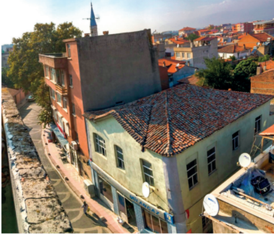
Şekil 1: Yapının kuşbakışı görünümü.
